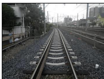
和歌山～田中口 竣工後
