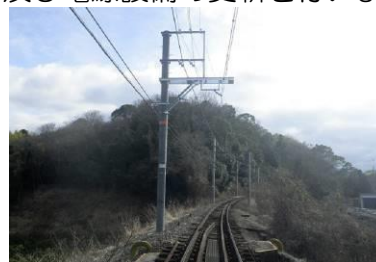
山東～大池遊園間 支持物更新 竣工後
