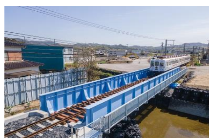
平尾第1橋梁（竣工）
