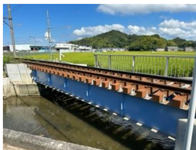
和田第5橋梁（竣工）
